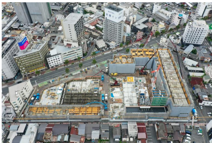
上空から撮影した写真（7月15日撮影）
